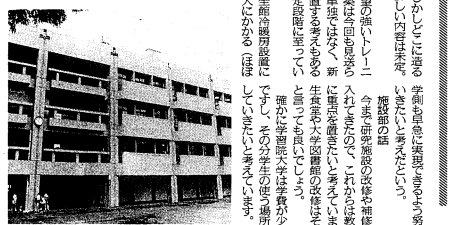
冷暖房化される北一号館
