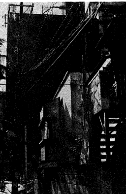
東池袋第一保育園(中央の白い建物)右のマンションは13階建て。その左に現在、10階建てマンションの建設中。さらにこの隣りに14階建てマンションの建設計画。
