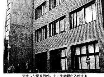
完成した南6号館。主に生命研が入居する
